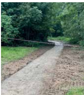
Oprava cesty pro pěší pod hřištěm.
