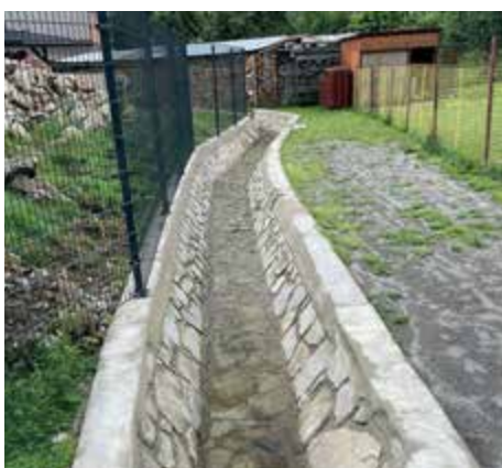
Oprava koryta Adámkovského potoka ve Zdíkově.
