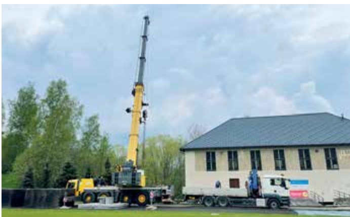
Při realizaci bylo nutné osadit za pomoci jeřábu i dvě 10 m 3 retenční nádrže.
