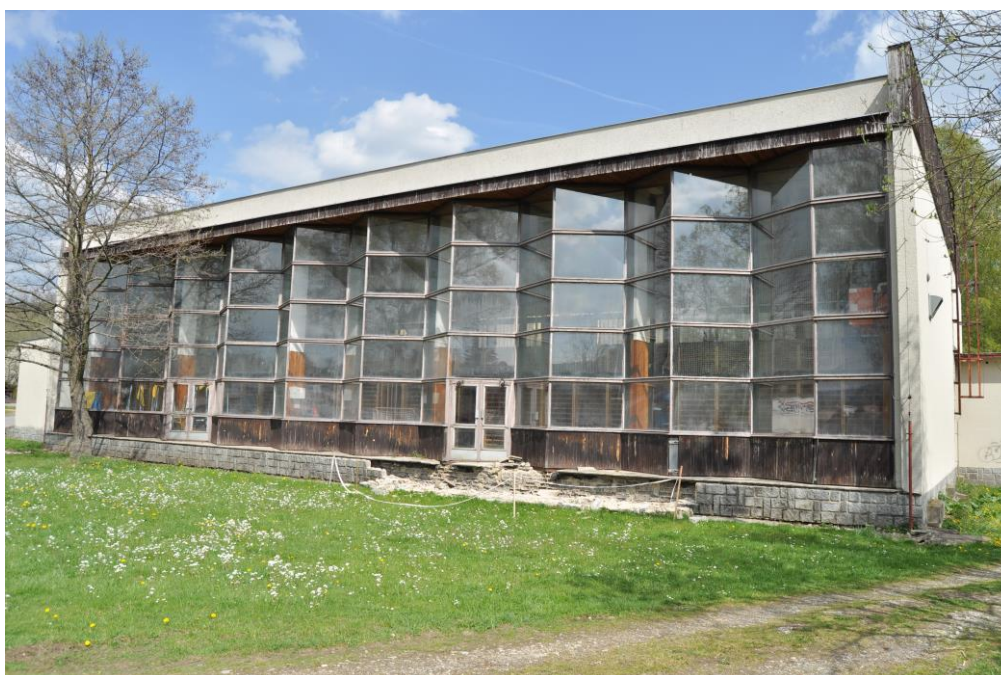
současný stav, pohled na západní stěnu
