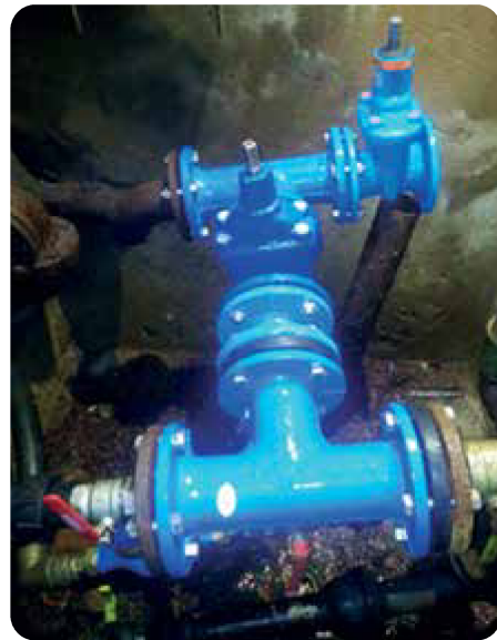
Částečně vyměněná armaturní sestava ve vodojemu v Masákově Lhotě.
